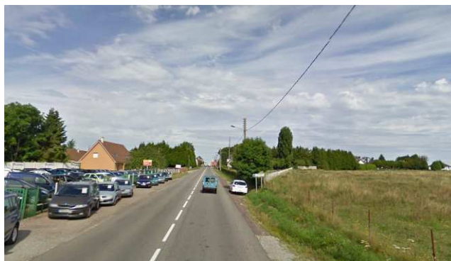
Entrée de territoire par la D313 (Saint-Ouen-du-Tilleul) peu valorisée : seule la présence du panneau de pays indique l'entrée de territoire, mais celle-ci n'est pas valorisée par son positionnement à côté d'un garage
