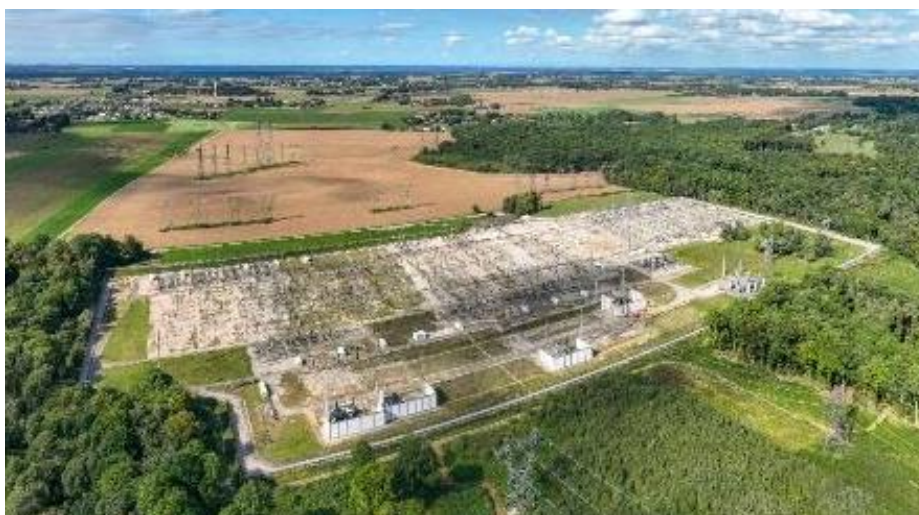
Figure 6 : Exemple de poste aérien (ici celui de Rougemontier)
