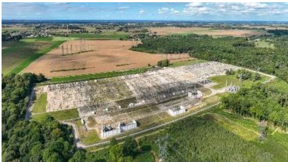
Figure 7 : Exemple de poste aérien (ici celui de Rougemontier)
