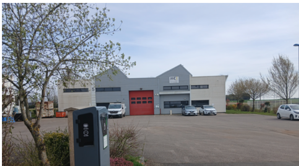
Zone d'activité appartenant à la CCRS à Trouville la Haule.
