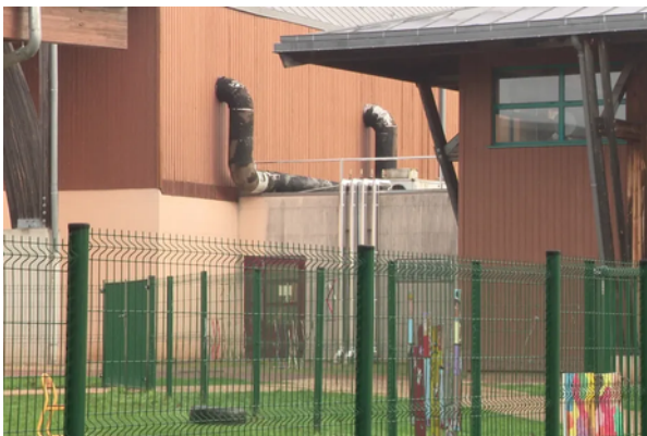
La commune d'Alizay (Eure) a inauguré, mercredi 27 janvier, une nouvelle chaudière biomasse, vertueuse et écologique, pour chauffer ses bâtiments communaux. • © France Télévisions
