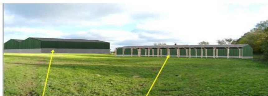
Silo 2 cases de 25 m x 27,10 m
