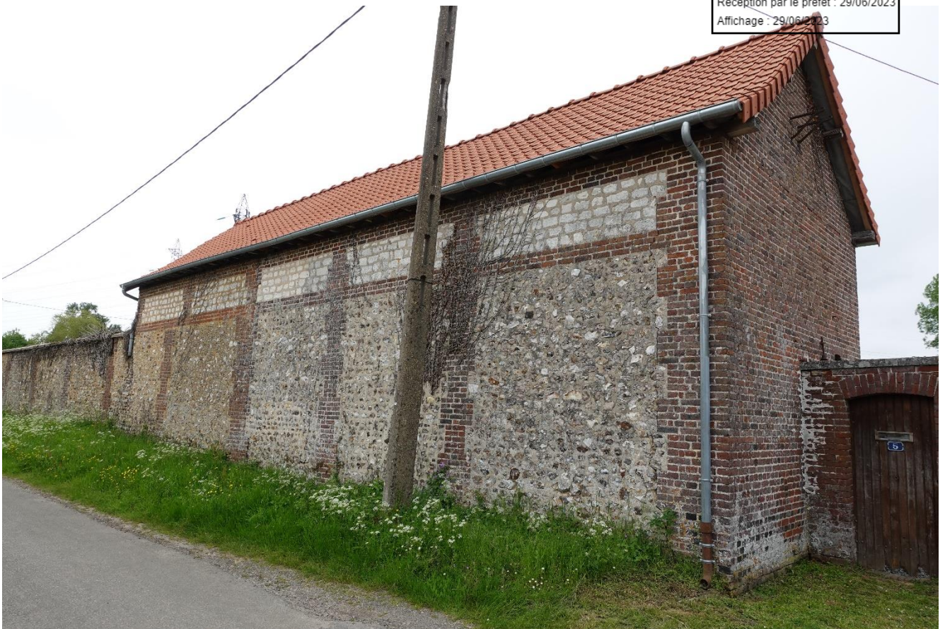
Le pavillon d'entrée (B3)
