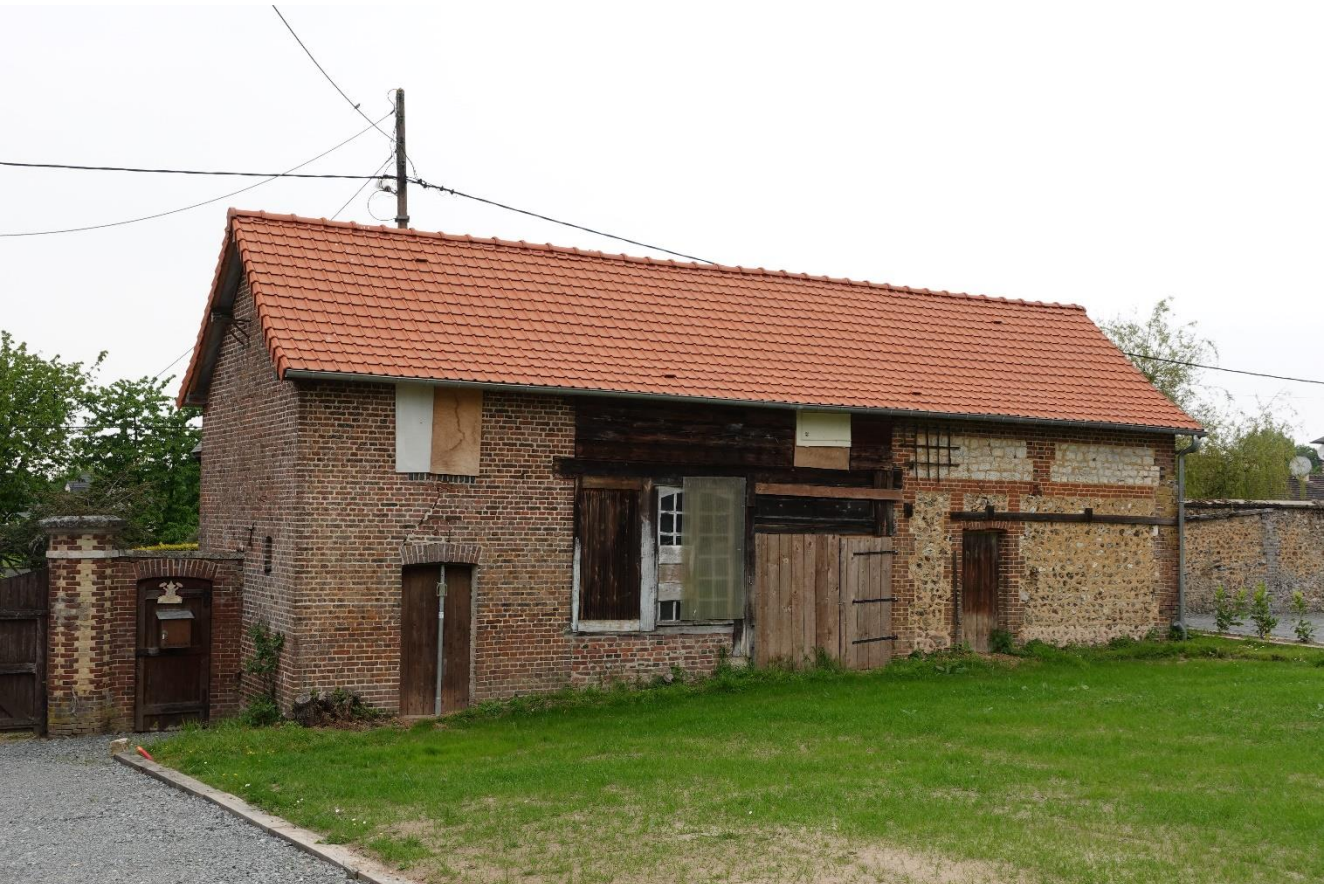
Le pavillon d'entrée (B3)
