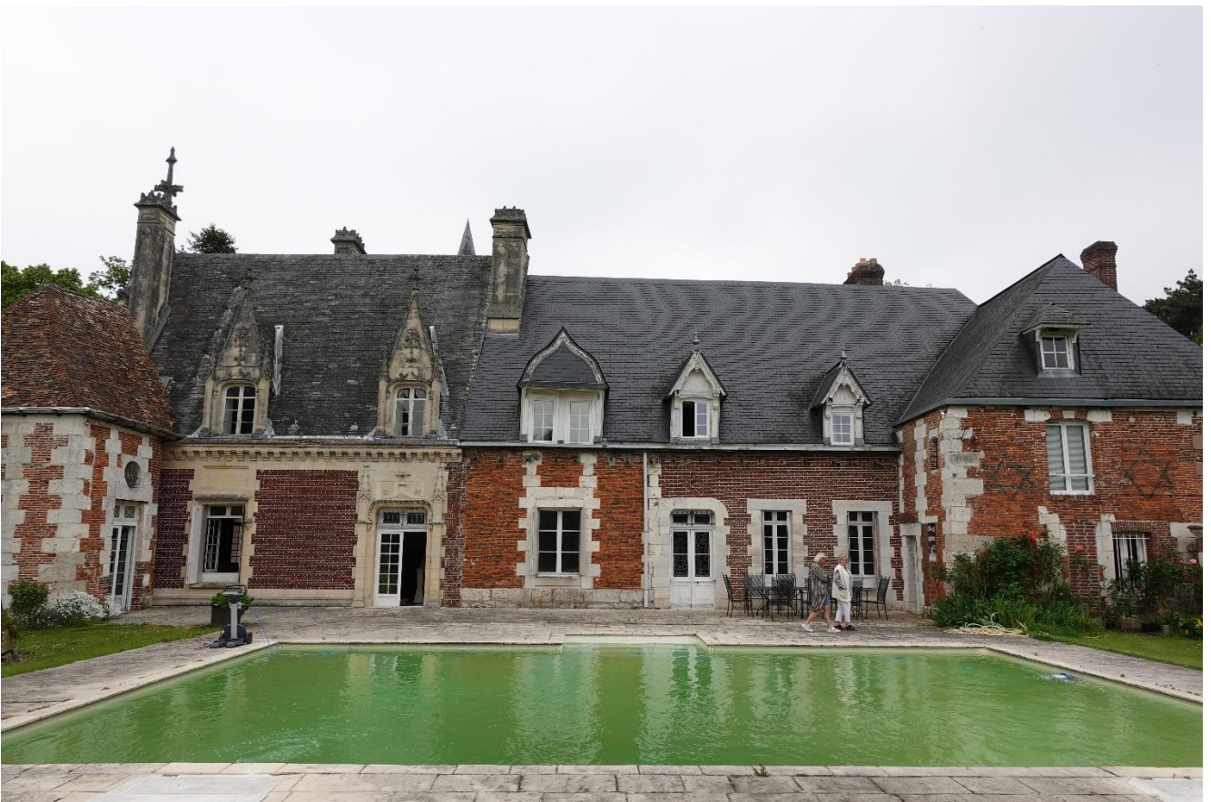
La façade arrière du manoir (B5)
