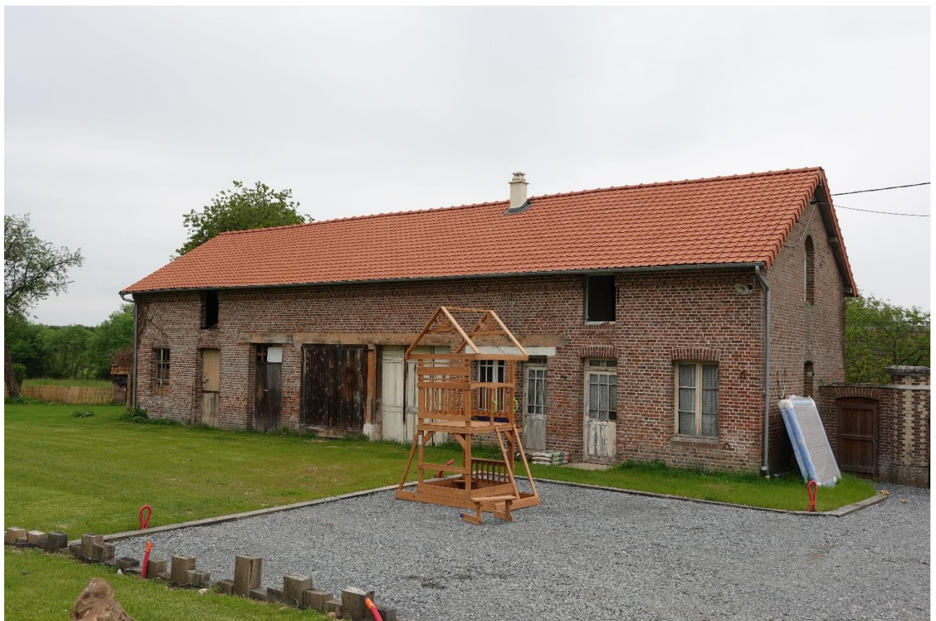
Le pavillon d'entrée (B4)
