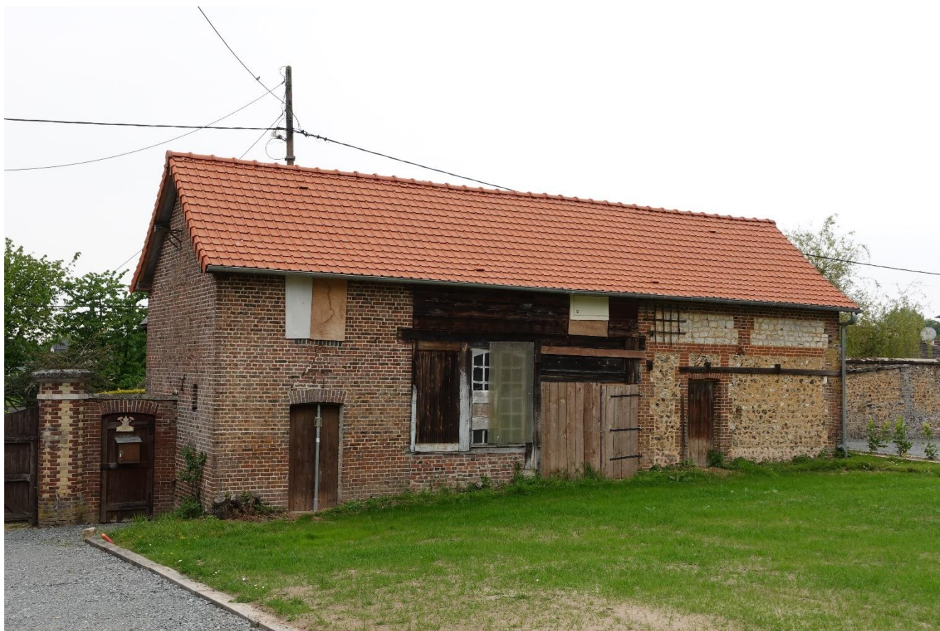
Le pavillon d'entrée (B3)
