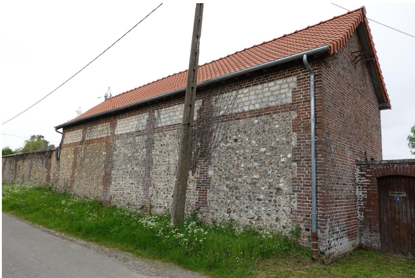
Le pavillon d'entrée (B3)
