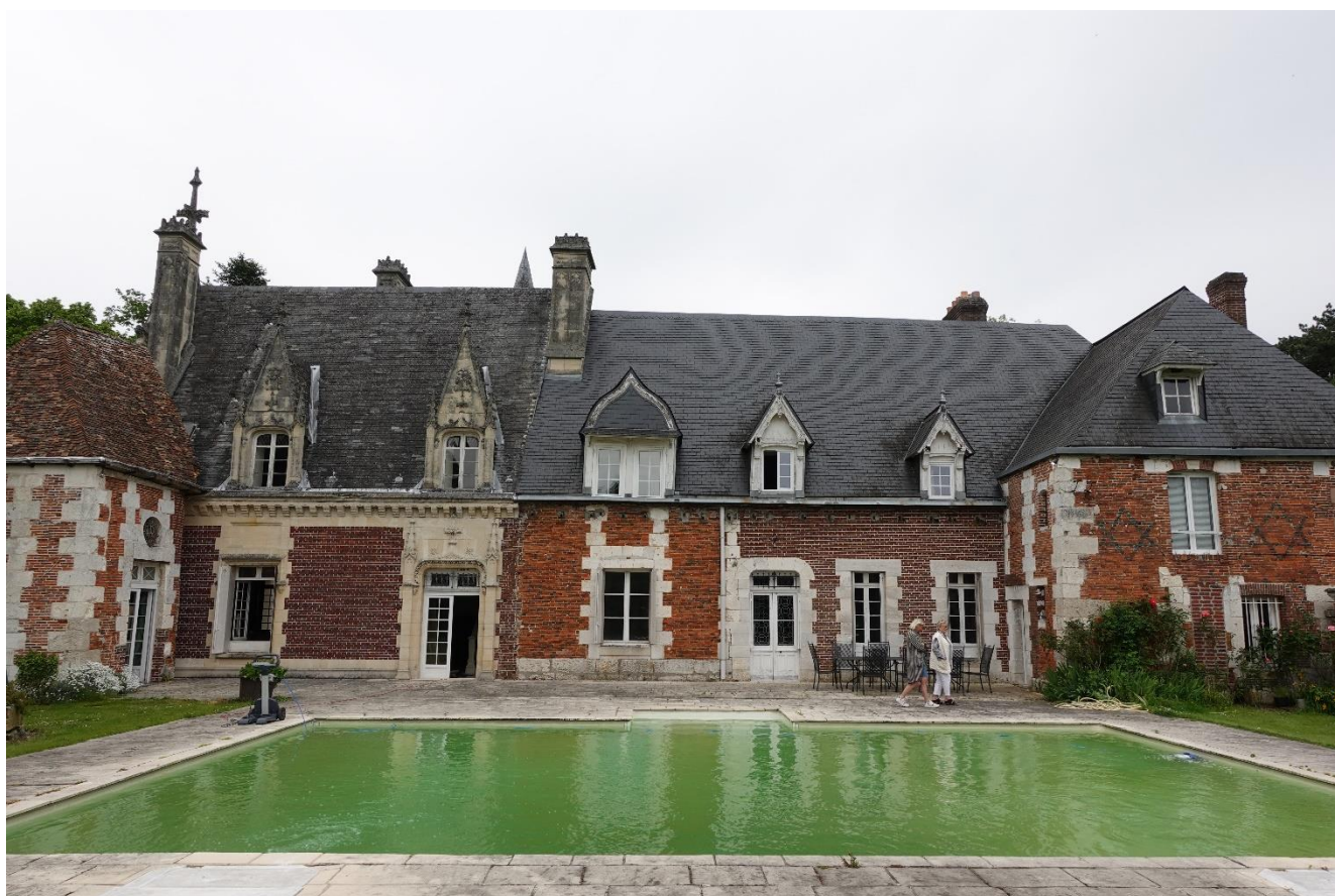
La façade arrière du manoir (B5)
