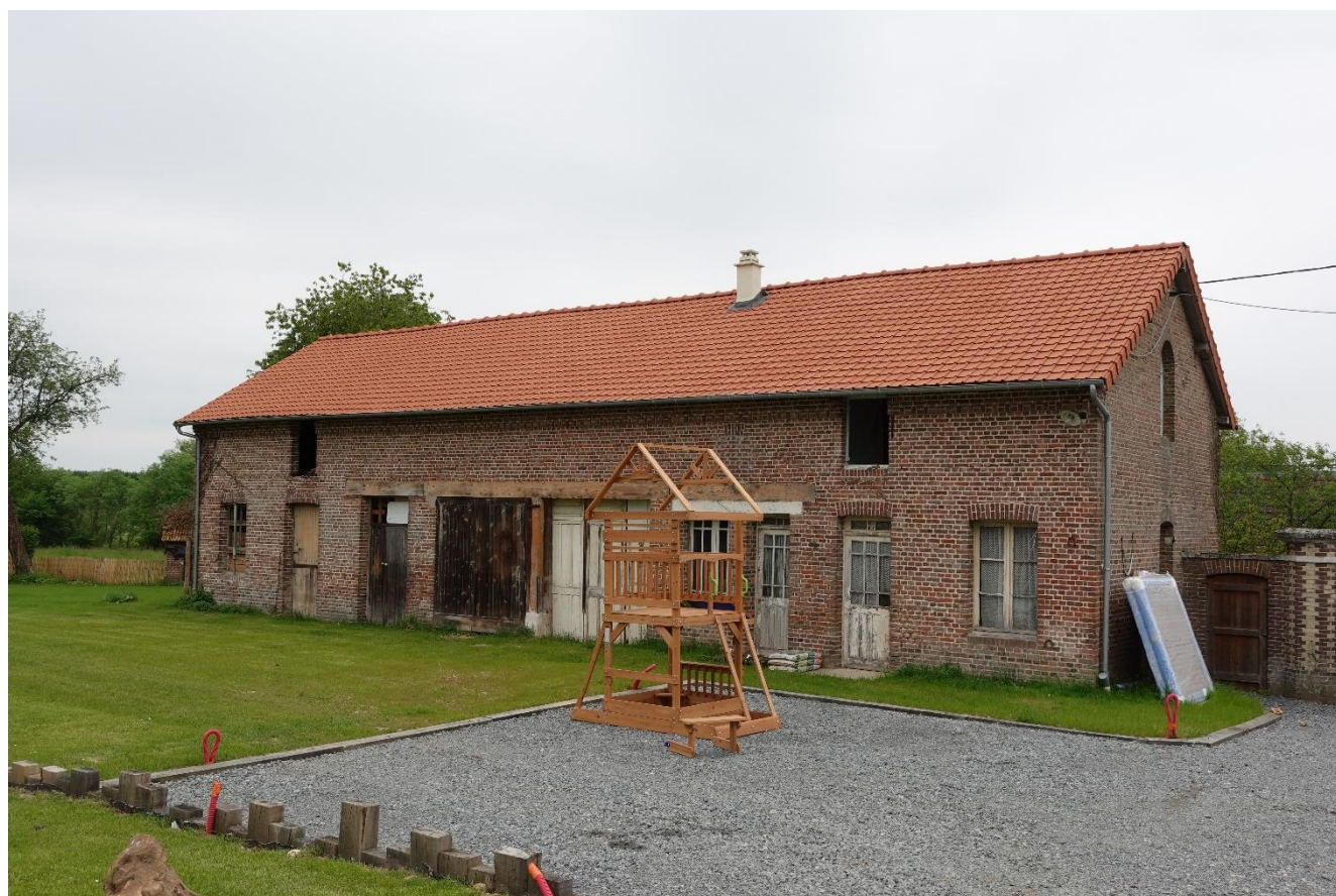
Le pavillon d'entrée (B4)
