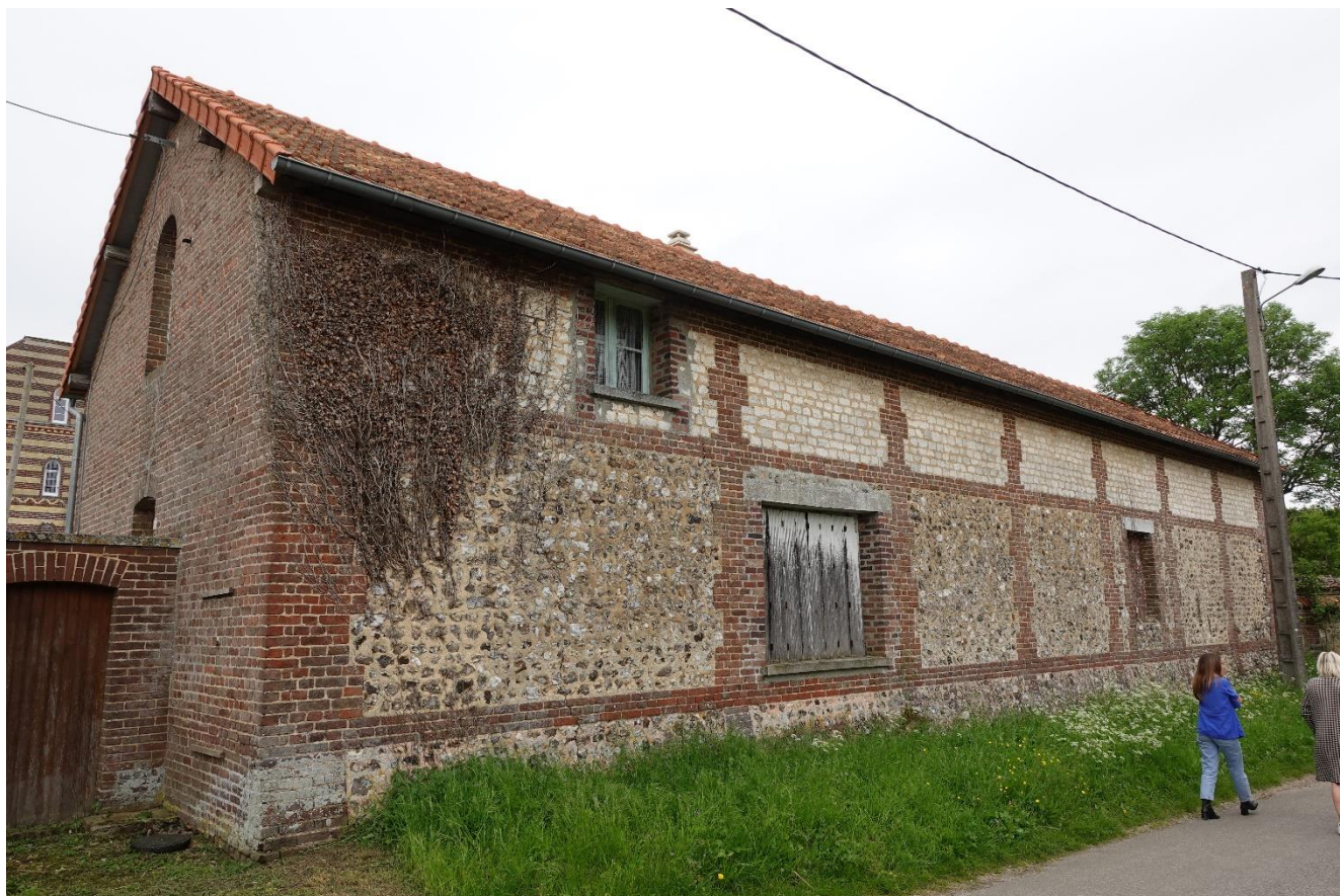
Le pavillon d'entrée (B4)
